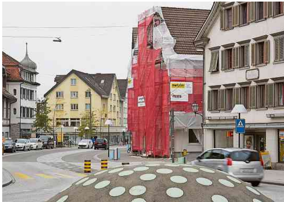
An der St. Gallerstrasse 23 (rot eingerüstet) gibt es bald eine weitere Pizzeria.
