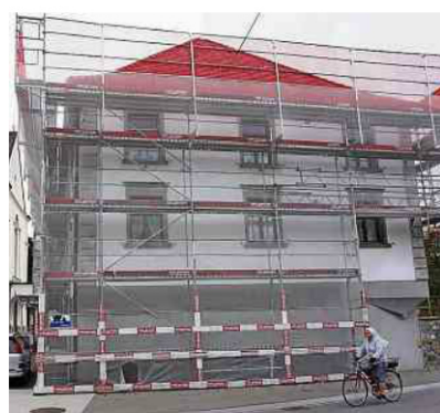
Das Pfarrhaus an der Herisauerstrasse mit Baugerüst.
